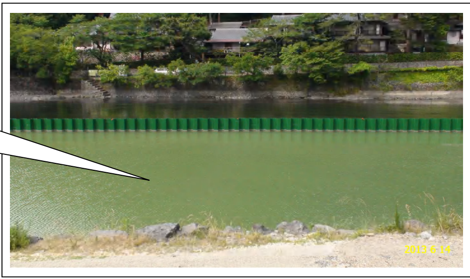
写真2 2013年6月14日 鋼矢板締切の内外では水質 汚濁の差は歴然。汚濁のため に透明度はほとんどない。
