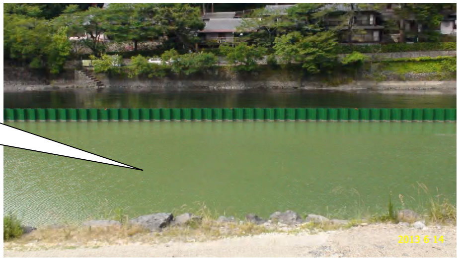
写真2 2013年6月14日 鋼矢板締切の内外では水質汚濁の差は歴然。汚濁のために透明度はほとんどない。
