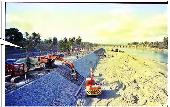
③82年大改修後の護岸(現在) 直線で急傾斜。砂洲は消滅。流心が岸の直近を流れる。
