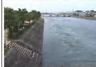
④ 掘削後の橋島。急斜面の護岸をつくった
