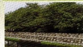
塔の川の流下能力の増大と遊船の利用に配慮した石積護岸とします。
