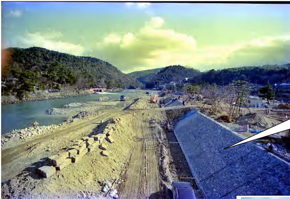
1982年 橘島東半分掘削と護岸工事 護岸を直線化、急傾斜、コンクリート化
