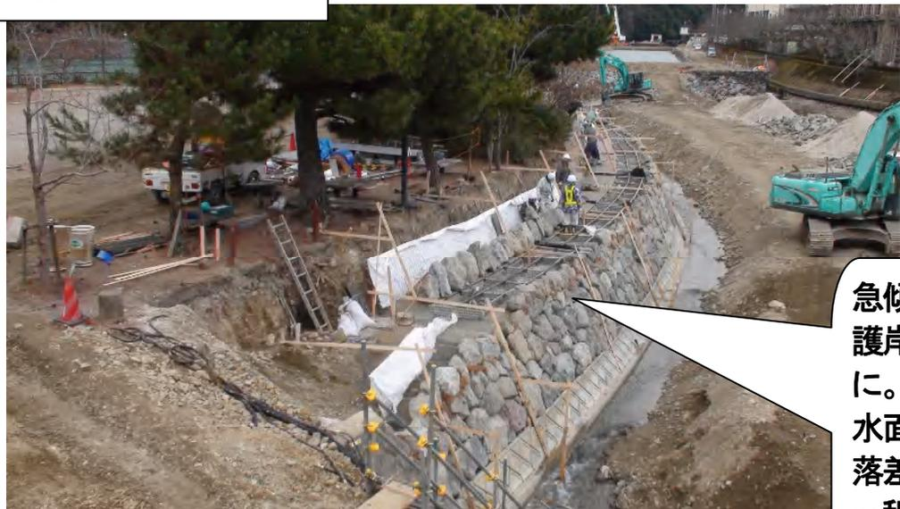
急傾斜の護岸の形に。水面との落差も2m程度と大きくなる。
